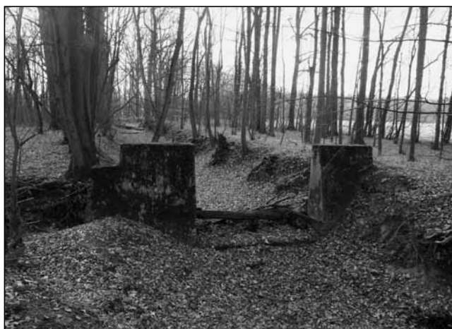
Betonové zbytky stavidla.
