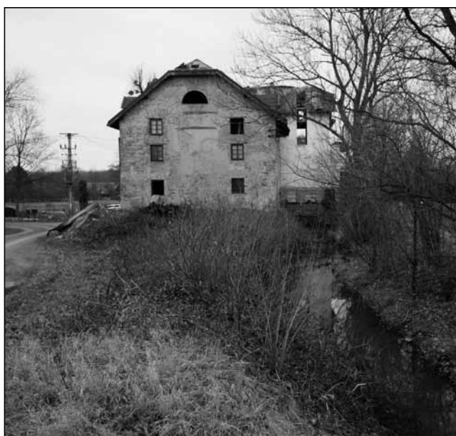
Objekt dřívějšího vodního mlýna s náhonem.
