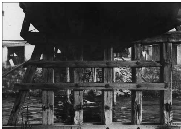
Detail konstrukce spodní části mostu, foto pravděpodobně nedlouho před zbouráním v r. 1958 (SOKA Nový Jičín, Sbirka..., sig. Lky/4-5).
