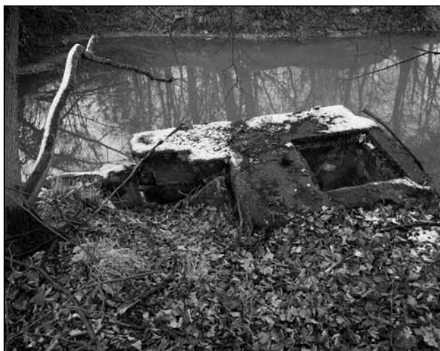
Betonové zbytky vpusti do vodárny na levém břehu Odry.
