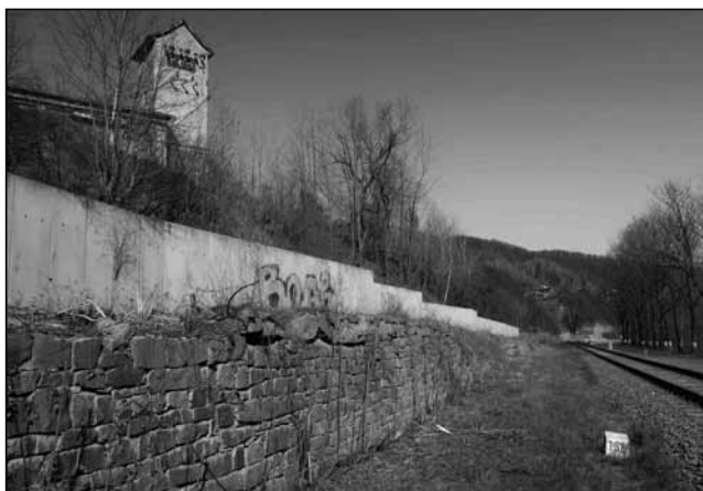
Místo, kde se nacházela vlečka – pohled od železničního přejezdu směrem k Jakubčovicím (Foto Emil Mateiciuc).
