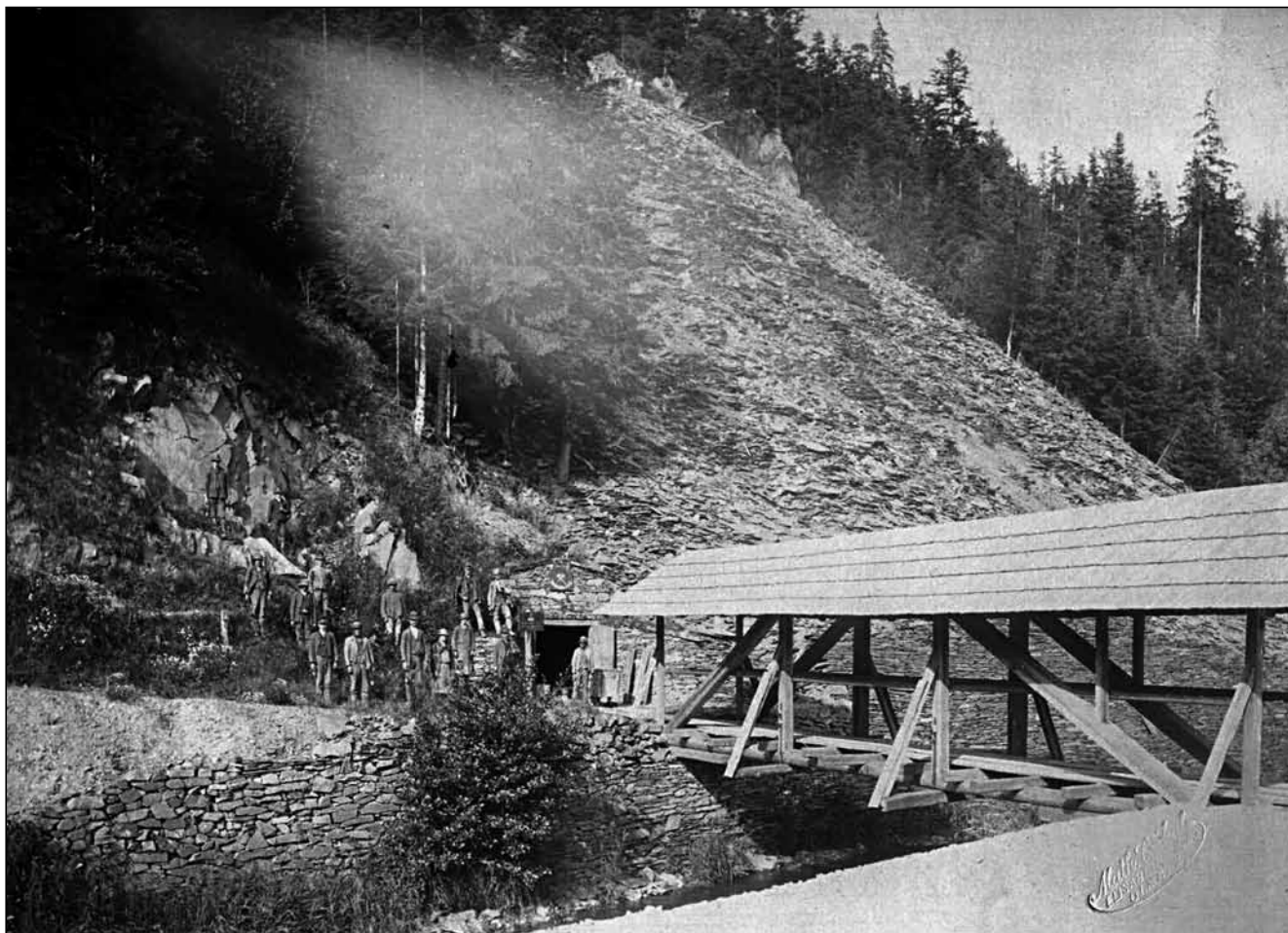
Horníci pózující před portálem štoly Willibald, za nimi mohutný odval z těžby břidlice a v popředí krytý most nad korytem Odry, jehož břehy jsou zpevněny zdi vyskládanou z kamene. Foto z roku 1890 je od olomouckého fotografa Matthiase Czihala (Poskytnul Emil Matejiuc).
