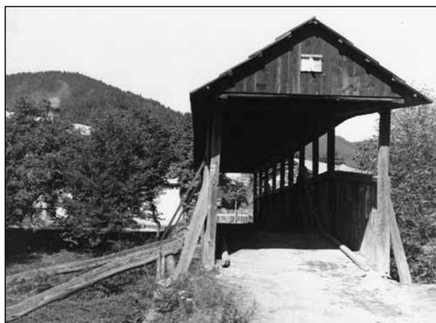
Pohled na vstup na most, r. 1936 (SOKA Nový Jičín, Sbirka..., sig. Lky/6).
