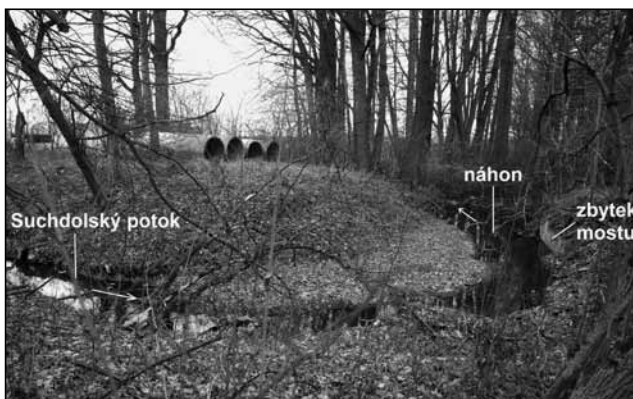
Místo dřívějšího mimoúrovňového křížení náhonu se Suchdolským potokem nedaleko železniční trati.
