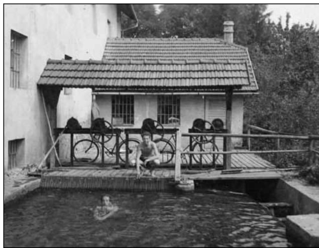
Na fotografii tzv. „Riviéry“ je patrné, že byla voda vedena přes česla vlevo na dvě turbíny a přebytečná voda odtékala přepadem vpravo mimo mlýnské zařízení (Foto archiv Zámku Kunín).
