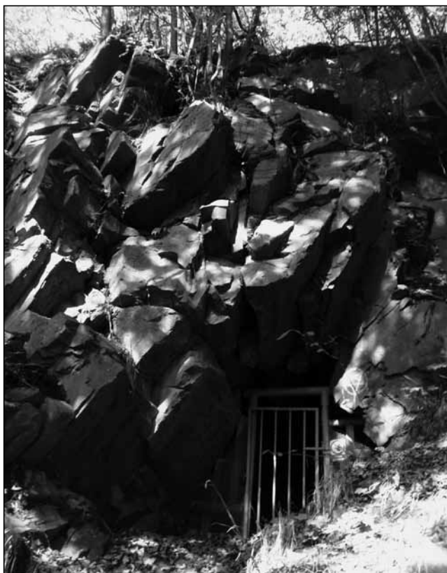
Vyústění odvodňovací štoly (údajně z heřmanických polí) ve svahu nad železniční tratí, r. 2018 (Foto Radim Jarošek).
