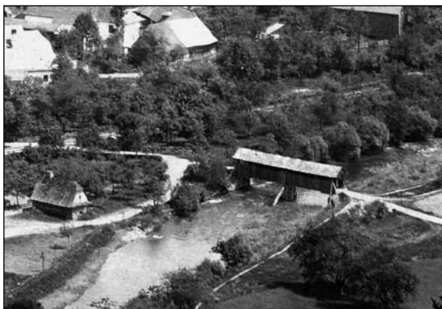
Krytý most v Heřmánkách – výřez z předchozí fotografie.
