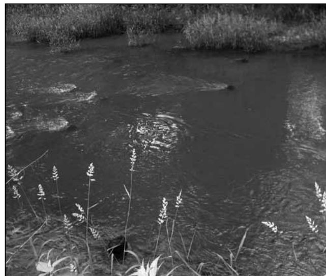
Za nízkého stavu vody lze vidět řady pilotů jezů (Foto D. Řičan, 2018).
