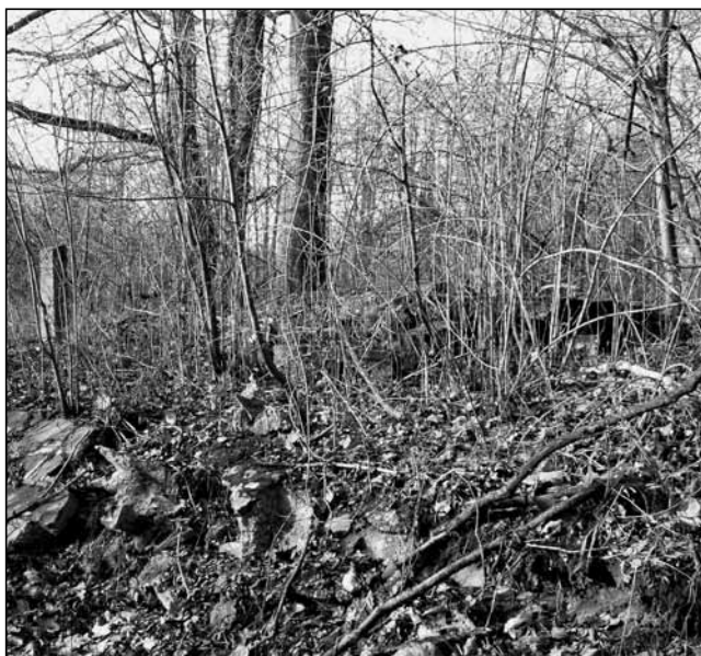
Dřevinným náletem zarostlé zbytky vodárny.
